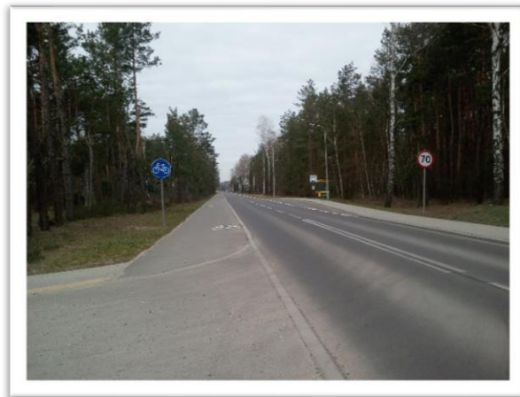
Fot. 29 wykonana nakładka bitumiczna na ul. Weteranów, gm. Radzymin
