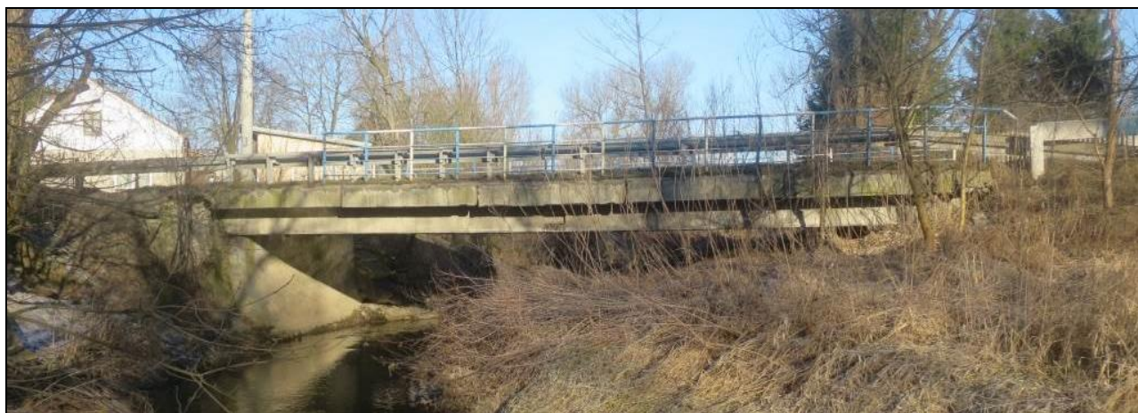
Rys. 1.2 Widok obiektu w terenie
